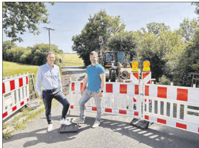
Bürgermeister Andre Stenda (links) und Bauamtsleiter Patrick Pingitzer begutachten die Baustelle.
